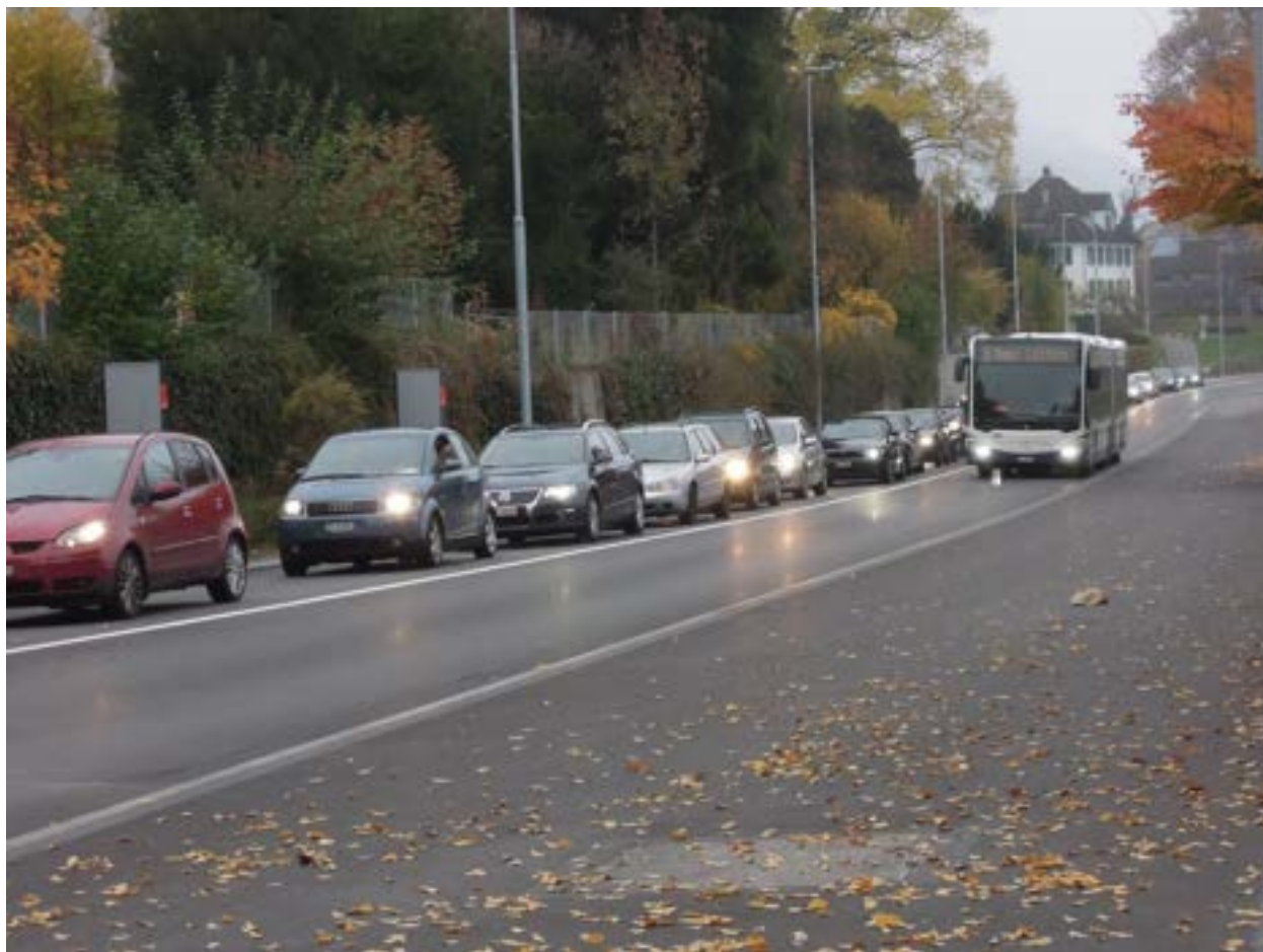
Abbildung 70: «Elektronische Busspur» an der Artherstrasse – Priorisierung des öffentlichen Verkehrs zu Stosszeiten (Massnahme M 3.01 ÖV-Feinverteiler auf Eigentrassee, Agglomerationsprogramm 1. Generation)
