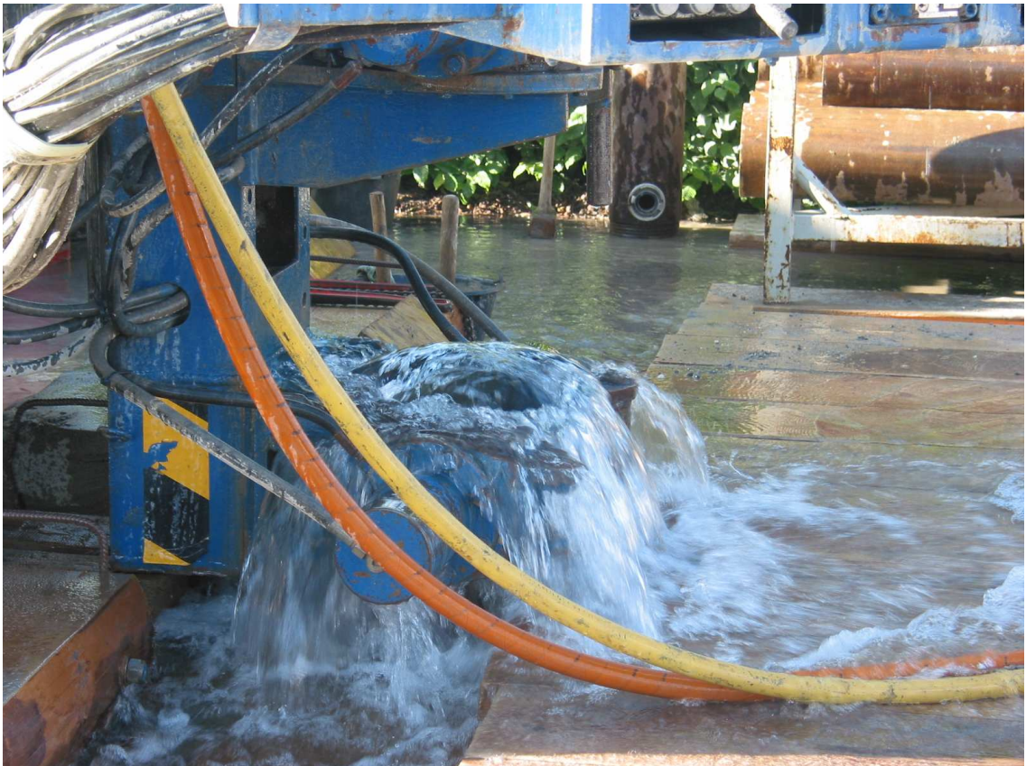
Artesischer Grundwasseraustritt beim Entnahmebrunnen KBZ Zug
